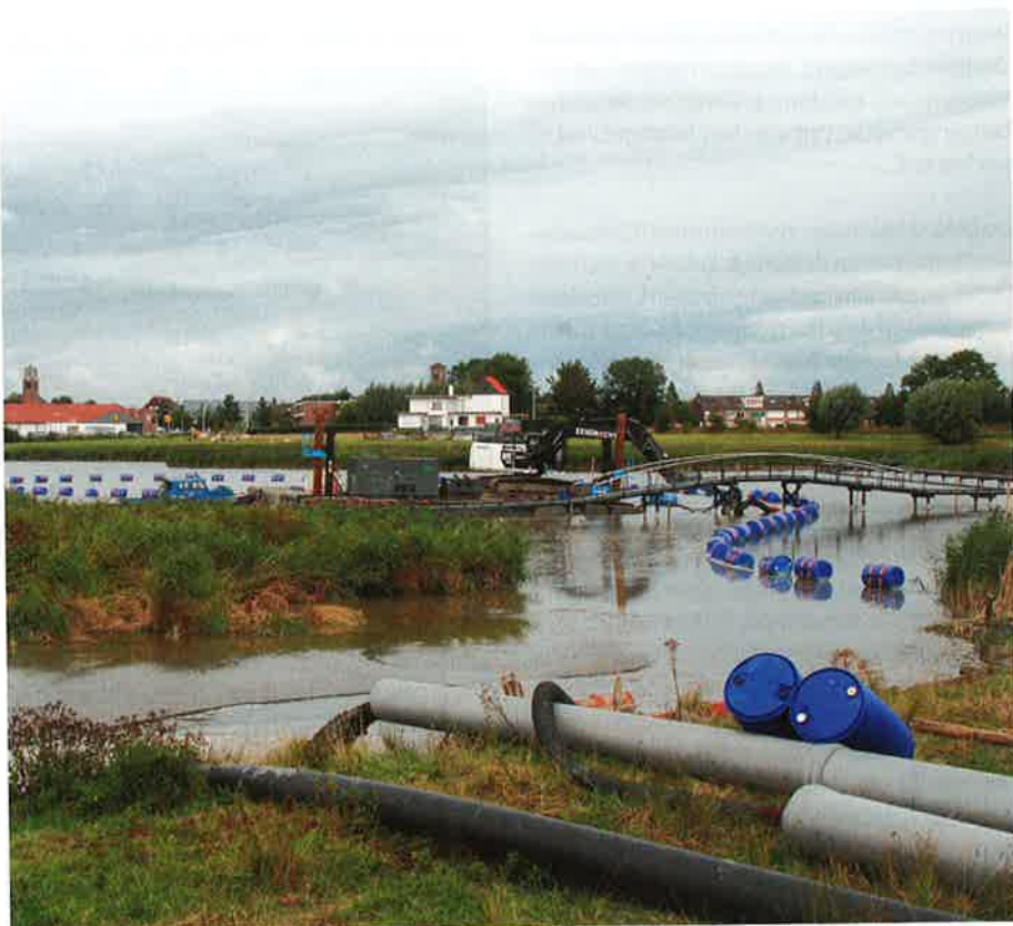
Het baggerwerk gebeurt gepantserd vanwege mogelijk nog aanwezige munitie.
